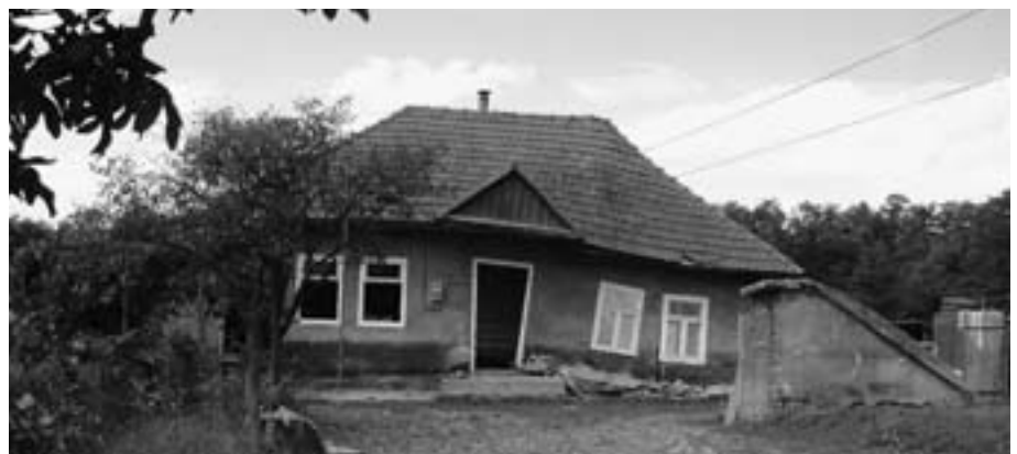
Eines der 90 000 Häuser, die durch das Jahrhunderthochwasser in Osteuropa beschädigt wurden.
